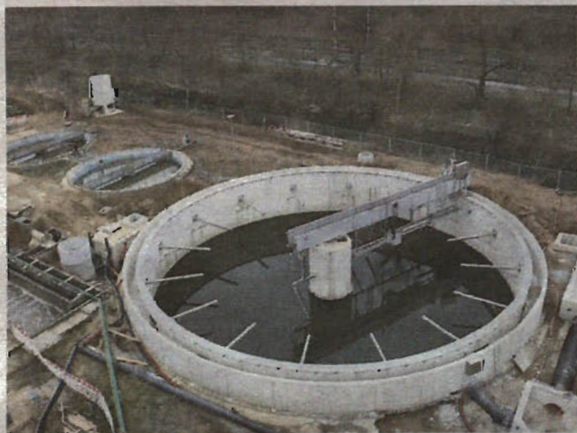
Les stations d'épuration, comme celle de Mersch (photo), font partie des compétences du Fonds pour la gestion de l'eau.
